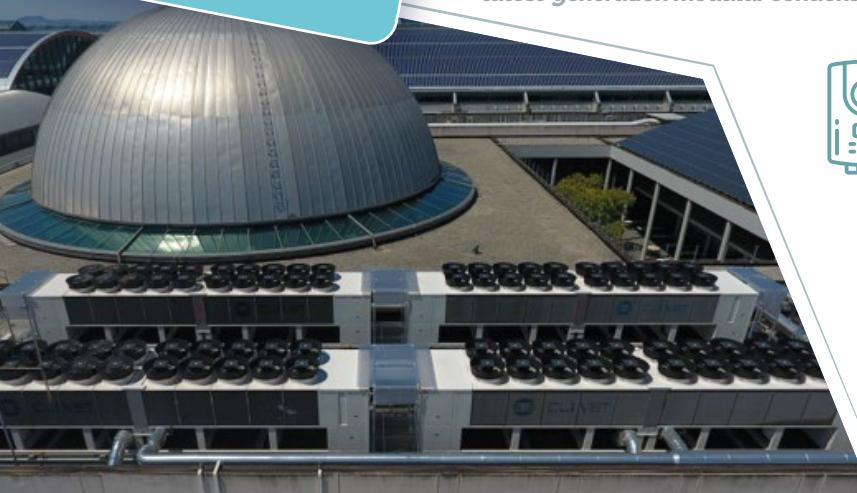
Il Condizionamento ed il riscaldamento del quartiere fieristico sono ottenuti con un impianto di pompa di calore costituito da 32 compressori con tecnologia inverter per una potenza massima di 1600 Kw, installato sopra la hall centrale che consente un notevole abbattimento dei consumi energetici rispetto ai sistemi tradizionali, tramite un impianto composto da due gruppi frigoriferi centrifughi dotato di torri di raffreddamento e una serie di caldaie tradizionali e a condensazione
