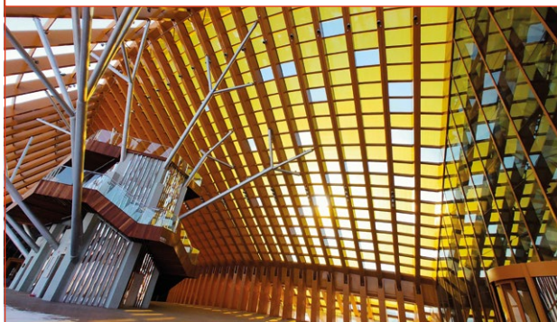
◆ FIGURA 4 Vetro fotovoltaico semitrasparente recante tecnologia a colorazione post-attiva
