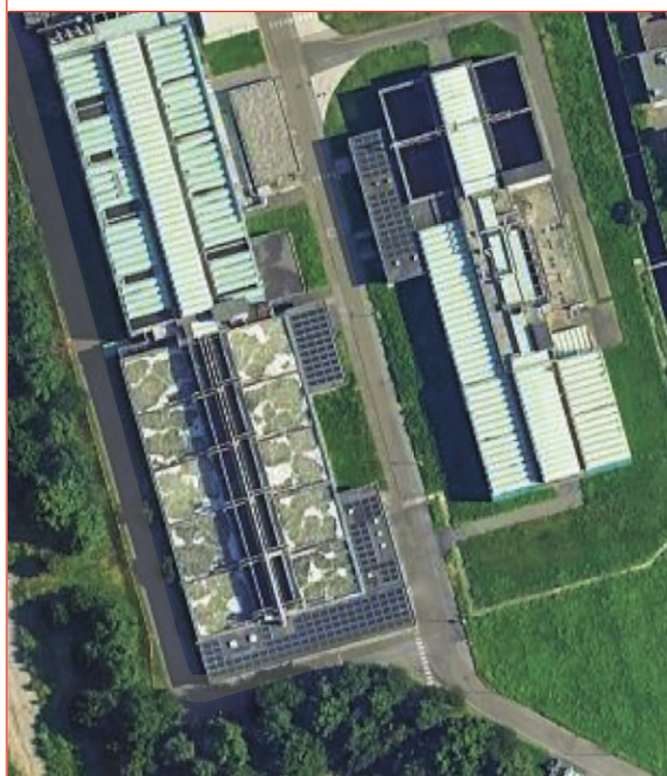
◆ FIGURA 8 Peschiera Borromeo - Impianti fotovoltaici FASE 1 – Vista dall’alto 2
