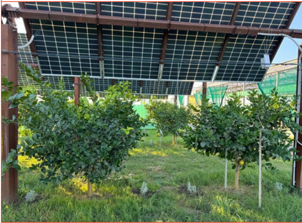
◆ FIGURA 6 Sistema agrivoltaico ad inseguimento con evidenza delle piante di lavanda messe a dimora
