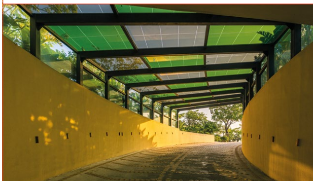
◆ FIGURA 3 Vetro fotovoltaico semitrasparente recante tecnologia a colorazione post-attiva
